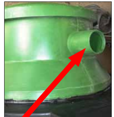
Anschluss für HT-Rohr DN150
